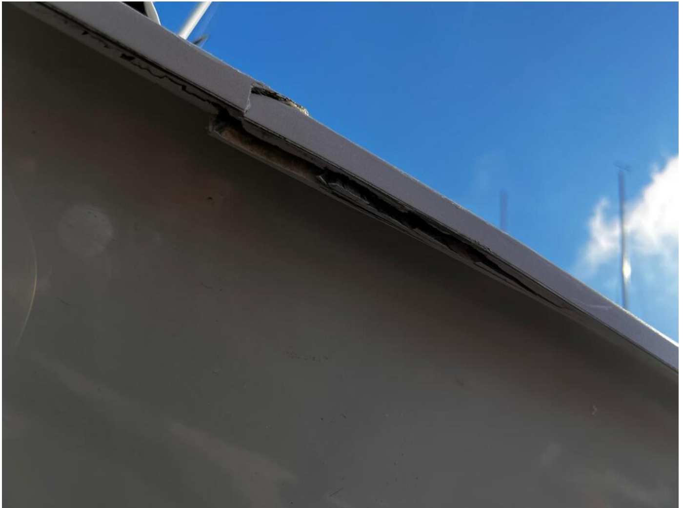
Daños en ARG 12733
